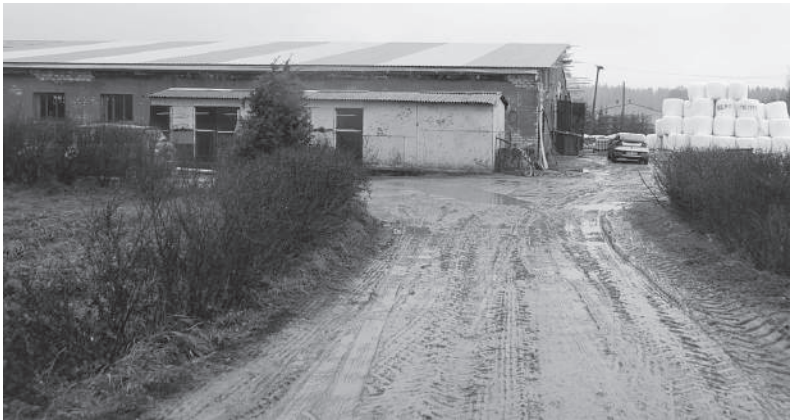
Darbštumo, gerų žmonių ir rėmėjų dėka po gaisro fermoms uždengti stogai, atliekami kiti rekonstrukcijos darbai.
